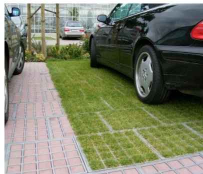
Självränerande Parkering: Kombination av gräs och sten
